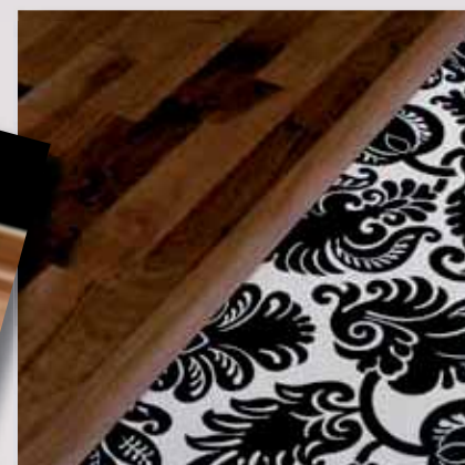
Listwy niwelujące stosuje się w celu uzyskania płynnego przejścia.
